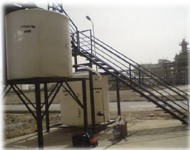
نمونه پکیج پرکلرین در حجم بالا با قابلیت باز و بست قطعات فلزی شاسی
